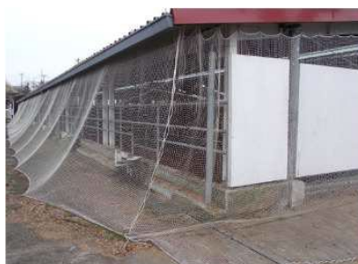
防鳥ネットの補修
