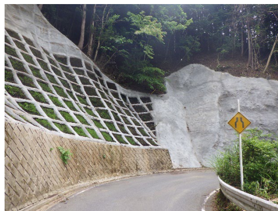
林道施設（法面保護工）
