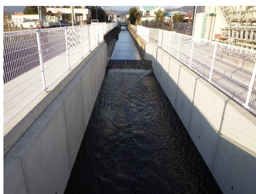
水路拡幅による洪水被害防止
