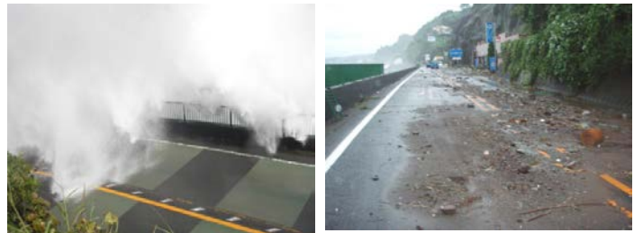
平成19年台風9号による越波被災状況
