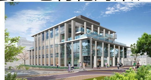
県立図書館新棟
