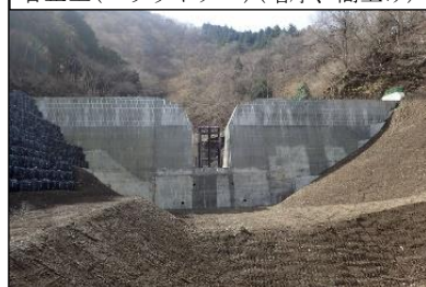
谷止工(スリットダム)(増厚、嵩上げ)
