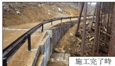
<L型鋼製擁壁施工状況>
