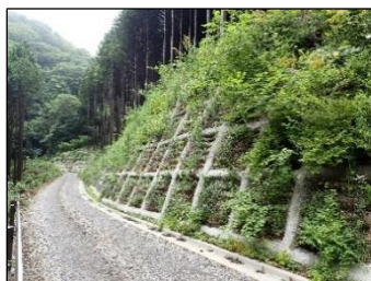
<法面緑化状況>
