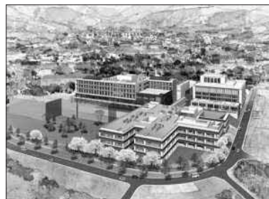
▲ 総合リハビリテーションセンター新病院棟、福祉棟
