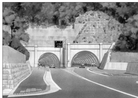
▲ 桜山トンネル
