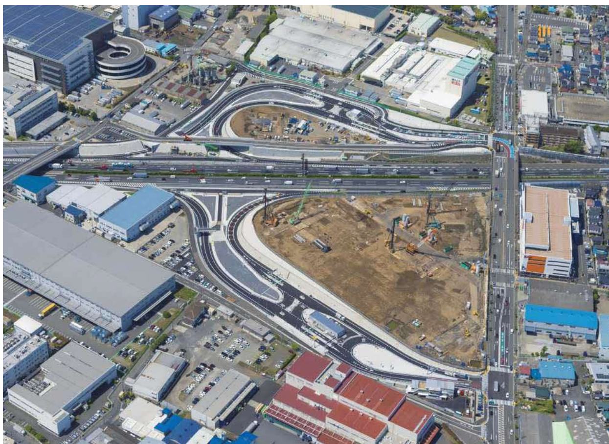
綾瀬スマートインターチェンジ
