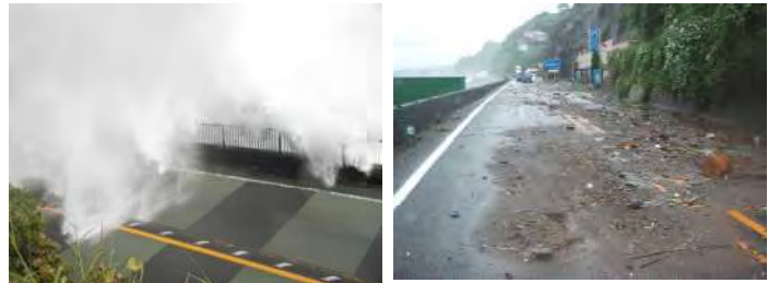
平成19年台風9号による越波被災状況
