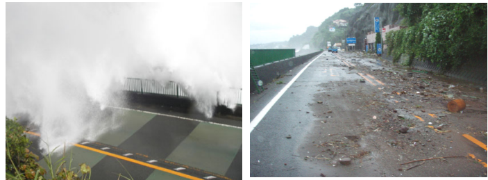
平成19年台風9号による越波被災状況
