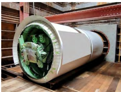
(工事写真 (シールド機))
