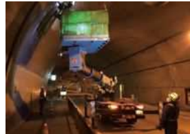
第2次産業の様子：トンネル工事（栗山町）
