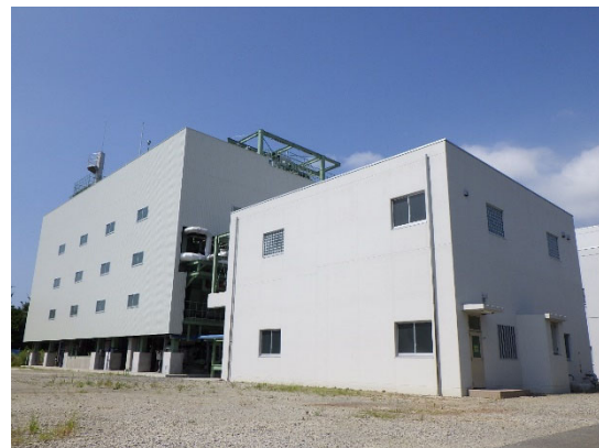
北系3号汚泥焼却設備 全景
