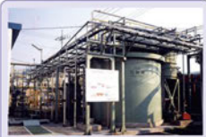
2 除害施設 工場、事業場排水の中には、下水管をつまらせたり、下水処理に悪影響を与えるものがあるので、そのような有害物質を取り除きます。
