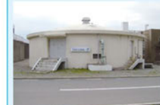
10 汚泥濃縮設備 最初沈殿池や最終沈殿池で底に沈んだ汚泥が集められ、濃縮し水分を減らします。
