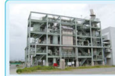
16 汚泥焼却炉 有機物を含んだ脱水汚泥をこの焼却炉で燃やすと灰になり、減量されます。
