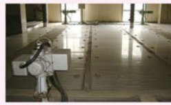
5 最初沈殿池 沈砂池からの下水をさらにゆっくり流して、細かい汚れを沈殿させ、水面に浮かんだスカム（油や野菜くず）を取り除きます。これで水はかなりきれいになります。沈殿した汚泥は汚泥濃縮設備へ送られます。
