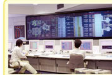
14 中央監視室 下水量や汚泥量の変化に応じて適切な処理ができるように、常時処理施設の運転状況を監視しています。
