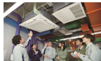
<設備実習のフロア(電気・空調)>
