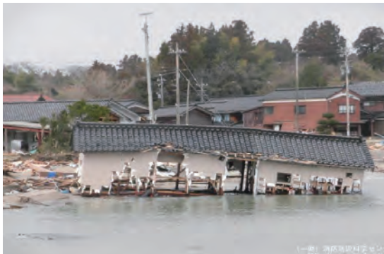
津波で流された建物（令和6年）
