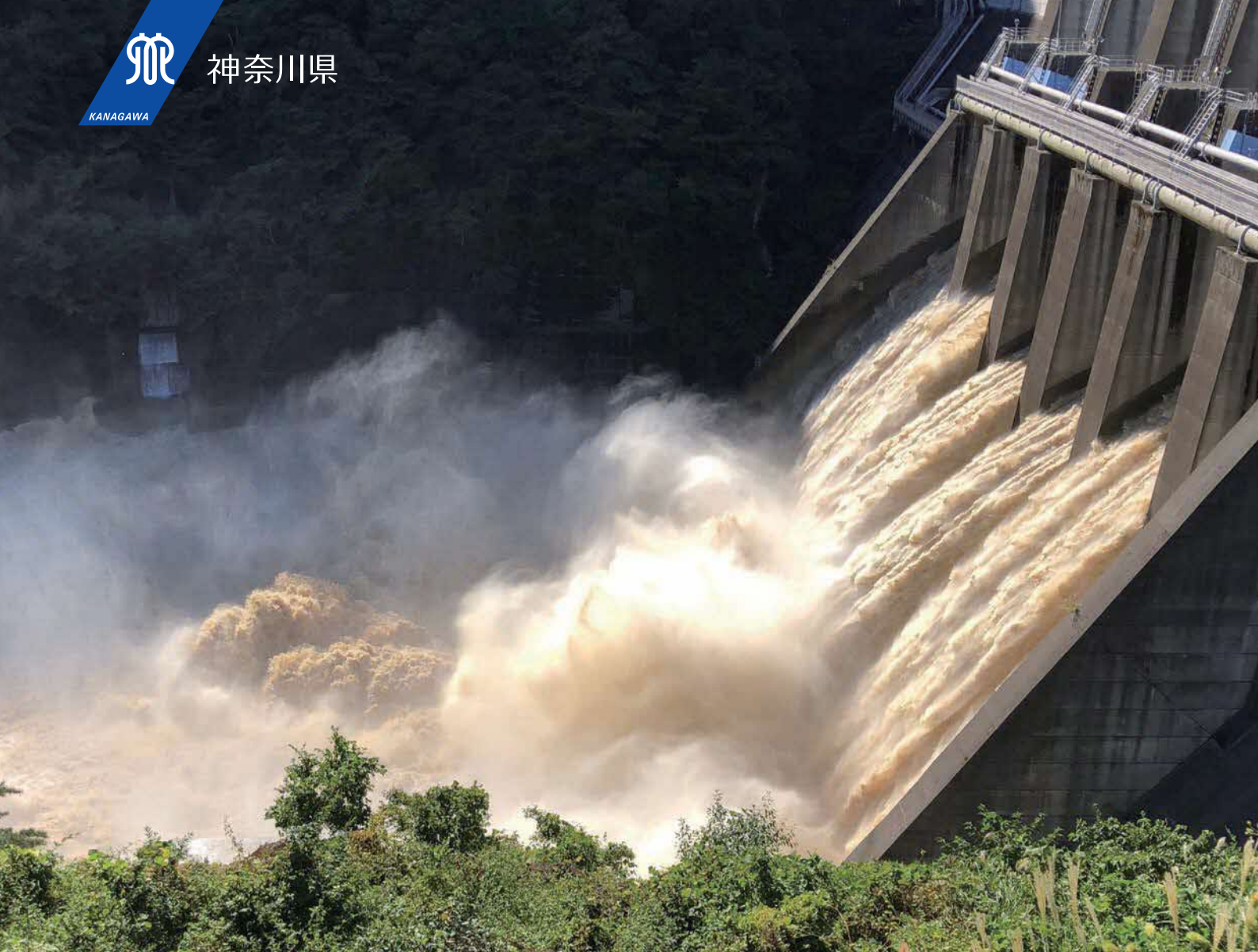
▲令和元年東日本台風通過後の城山ダム
