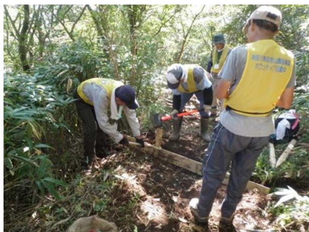
写真1 水切りの設置状況
