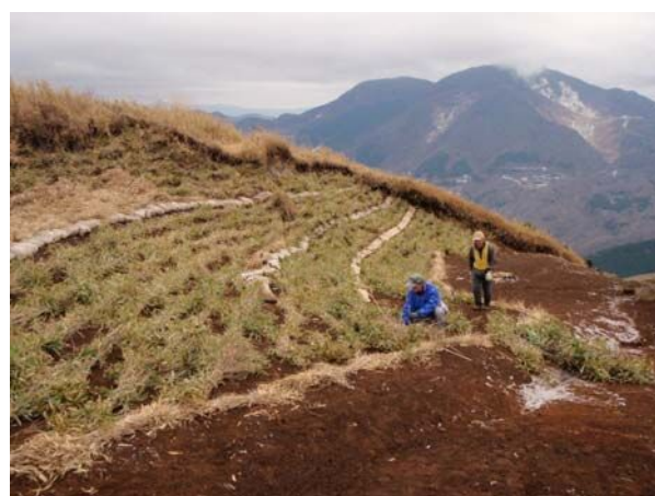
写真2 笹束による植生復元基盤づくり
