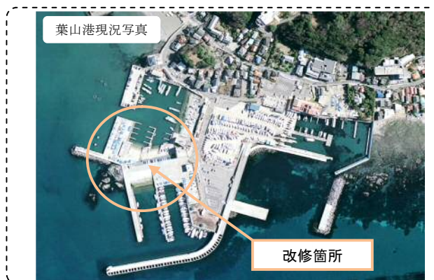
<船舶保管地の改修箇所>
