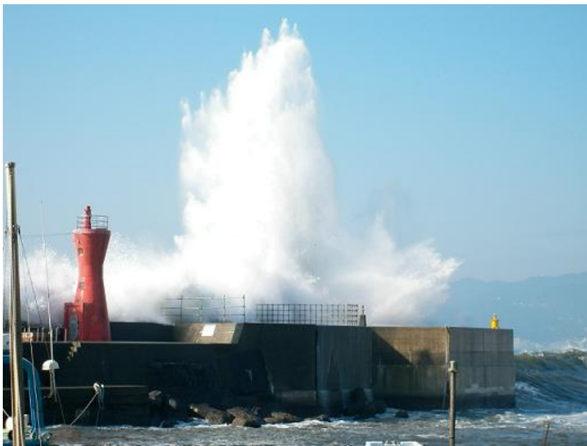
台風12号のうねりによる越波(福浦漁港) 撮影:福浦定置 2006.09.05
