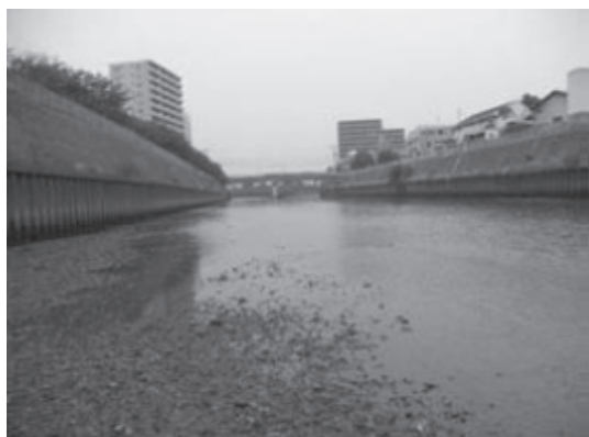
境川 St.49 新川名橋
