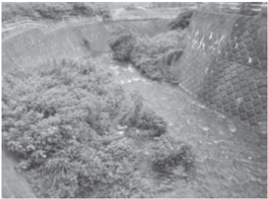
金目川 St.107 諏訪裏橋
