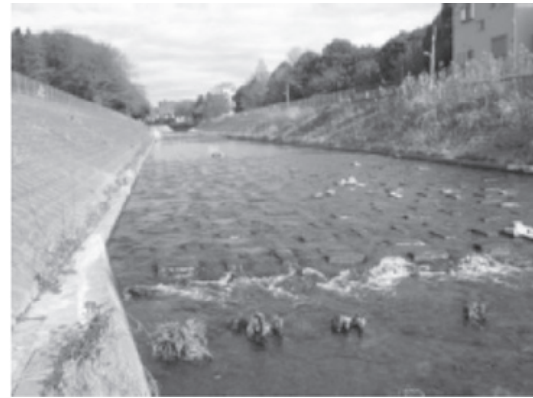
境川 St.44 鶴瀬橋
