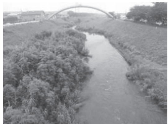
金目川 St.112 青井橋
