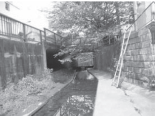
田越川 St.31 丸川橋
