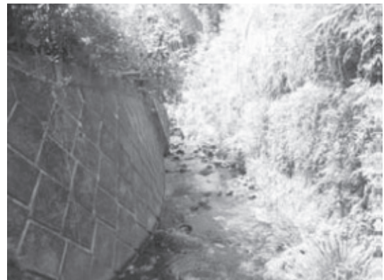
侍従川 St.16 金の橋
