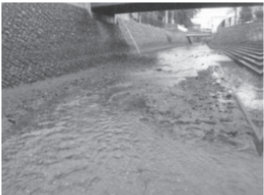
宮川 St.15 宮川橋
