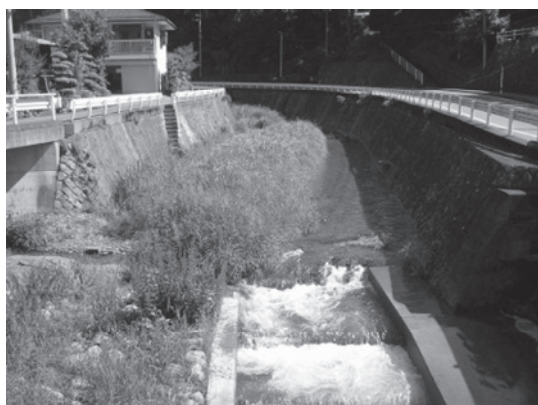
相模川 St.59 上沢井橋
