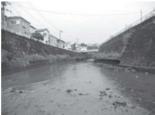
平作川 St.19 真崎橋
