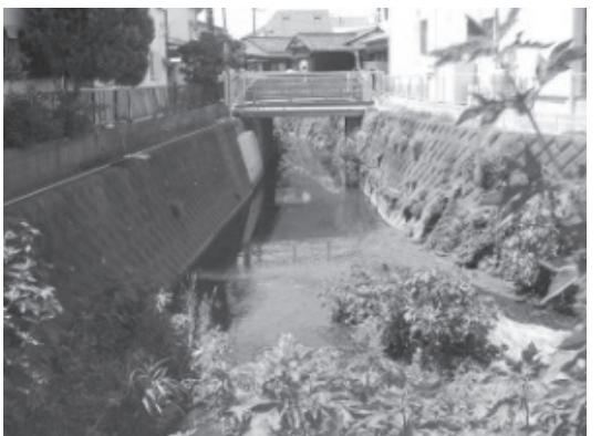
神戸川 St.39 日坂橋
