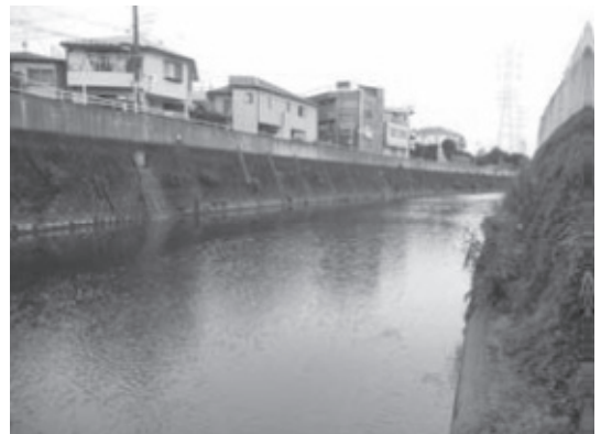
鶴見川 St.8 大綱橋
