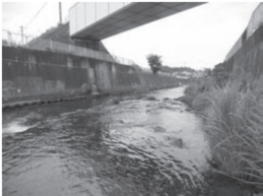
鶴見川 St.5 堀の内橋
