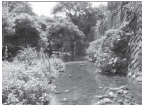
下山川 St.22 上山橋
