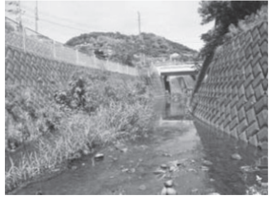
森戸川 (葉山) St.26 中町橋
