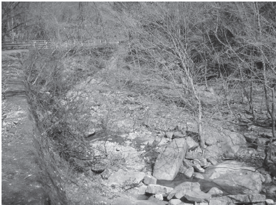
酒匂川 St.133 大滝沢・峰山橋
