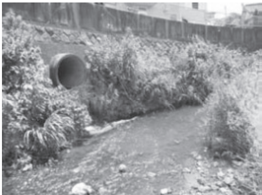
下山川 St.23 白石橋
