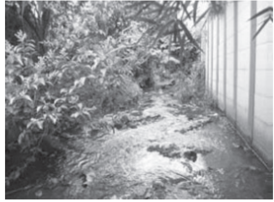
帷子川 St.10 大貫橋
