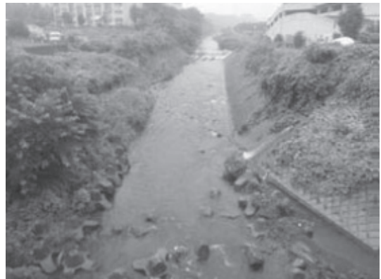
金目川 St.100 弘法橋
