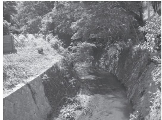
相模川 St.86 七沢川・二の橋
