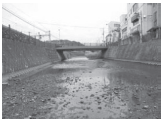
田越川 St.32 逗子橋
