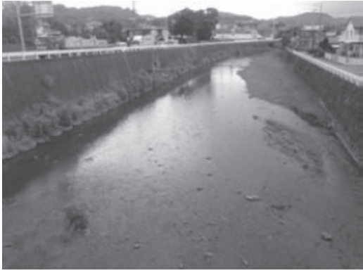
中村川 St.121 押切橋
