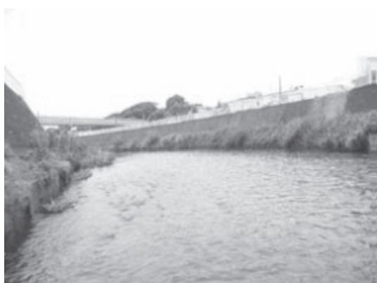
引地川 St.53 石川橋
