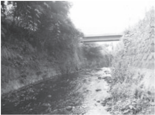
大岡川 St.13 日下橋
