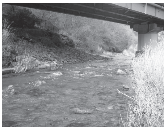
酒匂川 St.152 湯ノ沢橋
