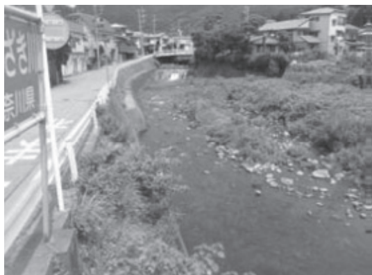
新崎川 St.177 吉浜橋
