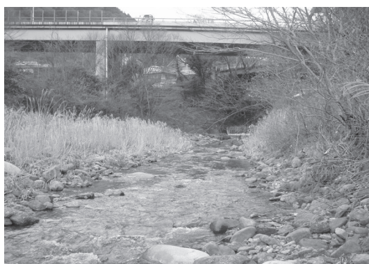
酒匂川 St.147 新樋口橋
