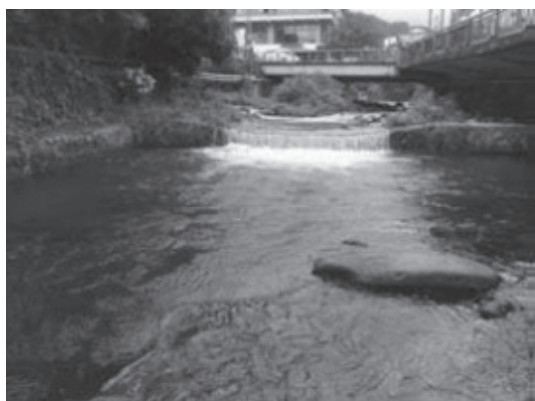
千歳川 St.180 落合橋
