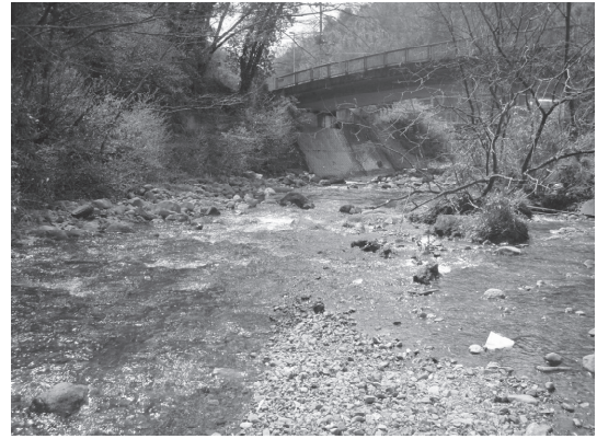
酒匂川 St.154 河内橋
