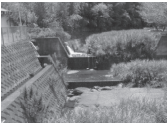
山王川 St.165 下河原橋
