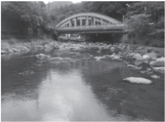
早川 St.171 須雲川橋
