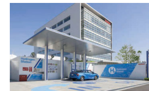
中規模 水素ステーション
