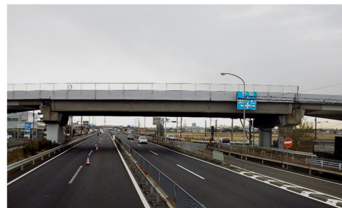
写真2-2 上平間架道橋 (県道44号(伊勢原藤沢)/伊勢原市)
