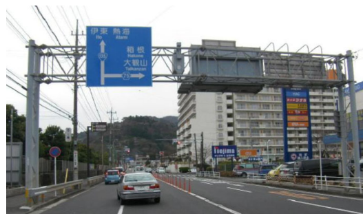
写真2-6 門型標識(国道135号/湯河原町)
