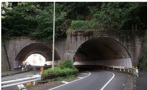
写真2-3 竜宝寺トンネル (県道402号(阿久和藤沢)/鎌倉市)
