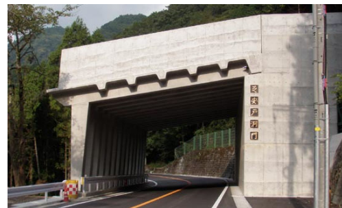
写真2-4 芝安戸洞門 (県道76号(山北藤野)/山北町)
