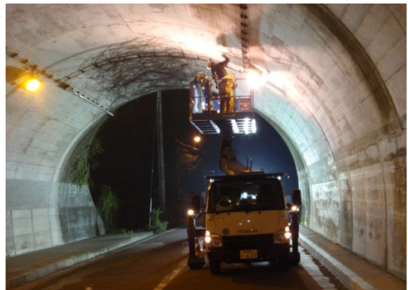
写真3-1 トンネル点検状況
