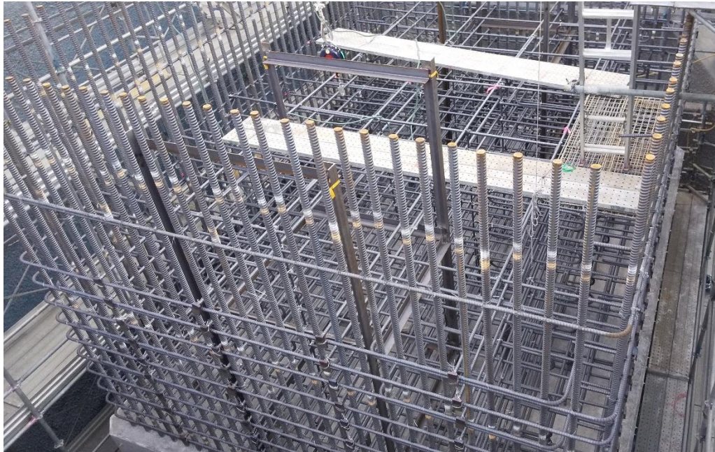
対象鉄筋の全体像
