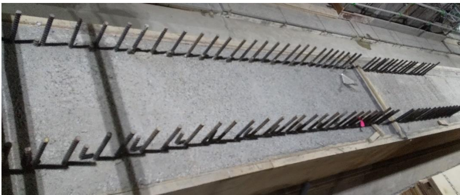
対象鉄筋 1 (トンネル床面)
