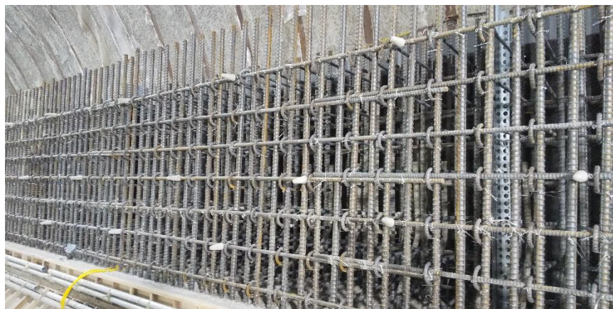
対象鉄筋 2 (トンネル側壁)
