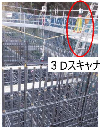
実証実験場所 1 神奈川県内橋梁下部工工事現場
