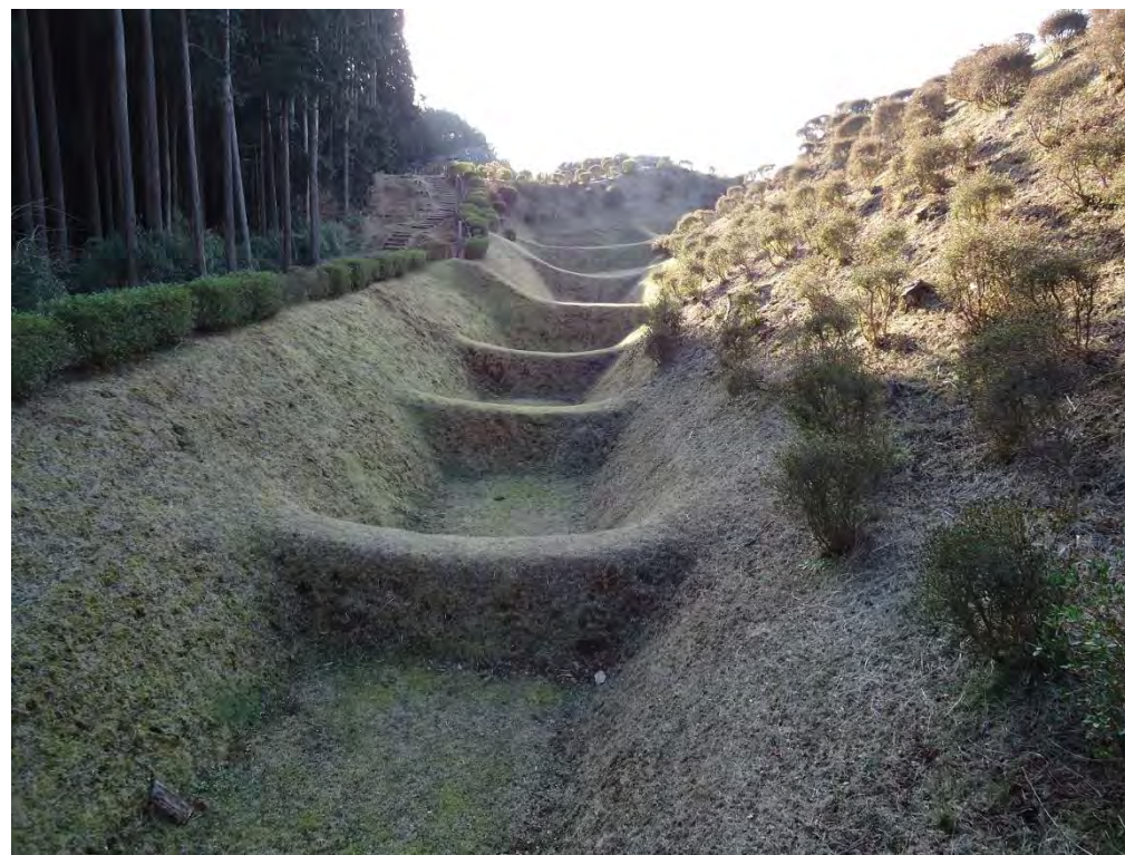
山中城畝堀(静岡県)
