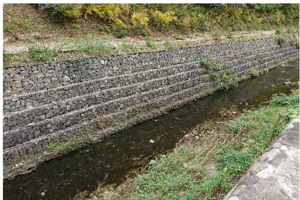
護岸に多孔質材を使用 注
