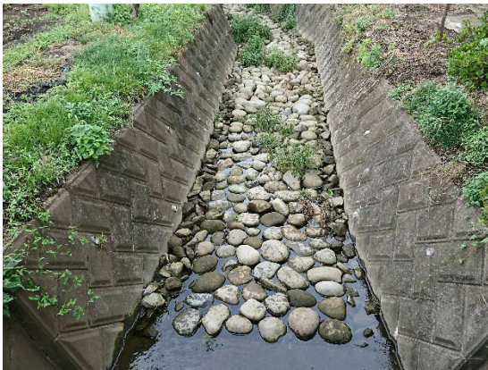
河床に礫を敷く
