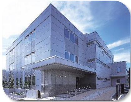
中原テクノセンター2号館
