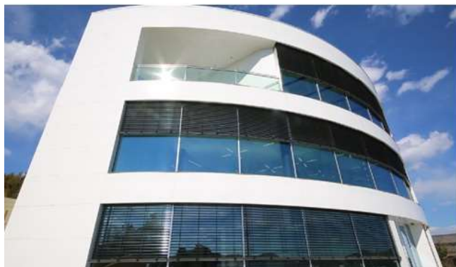
【藤崎建設工業本社ビル】 (外観、太陽追尾式外付けブラインド)
