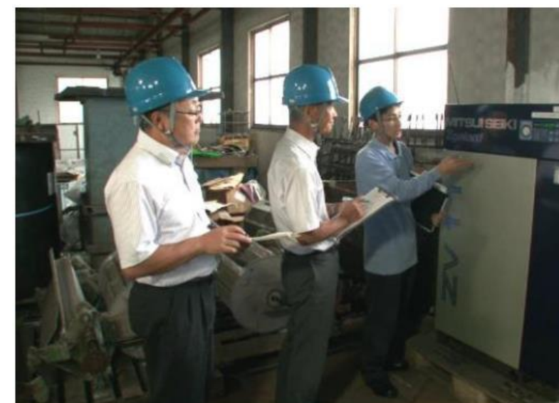
<現場でのエネルギー使用状況確認>
