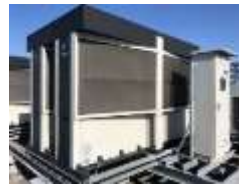
AHU (外調機) 12台 (再熱チリングユニット) 2台
