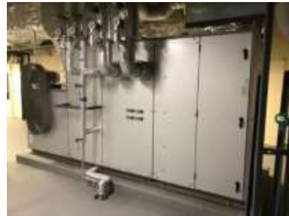
AHU (外調機) 12台 (再熱チリングユニット) 2台
