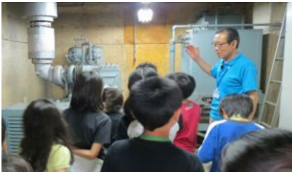
普通は見られない自家発電システムです。
