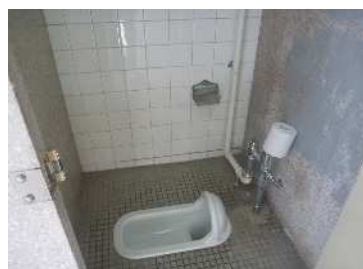
【トイレ改修イメージ】 <改修前>
