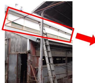
写真2 排気口を覆った事例（左：赤枠の部分に遮光ネットを設置、右：遮光ネットを設置したところ）
