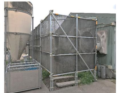
写真3 閉鎖型豚舎の排気口を覆った事例
