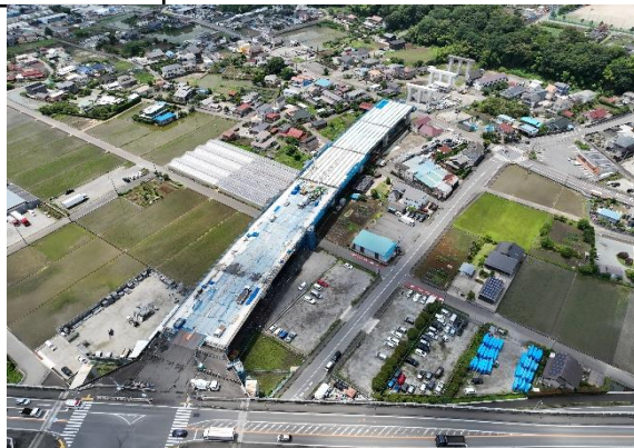
高架工区 (R5.6撮影)
