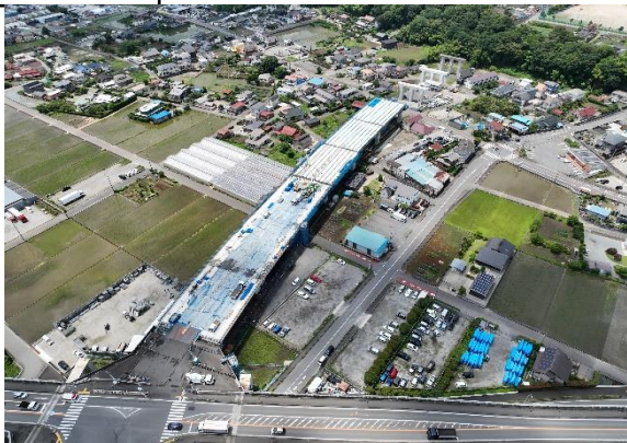
高架工区 (R5.6撮影)
