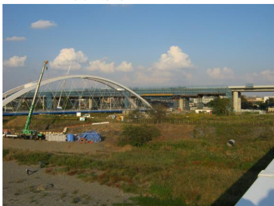
高水敷掘削工施工前
