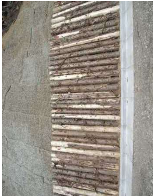
支障木を使用した丸太伏工(H22施工)
