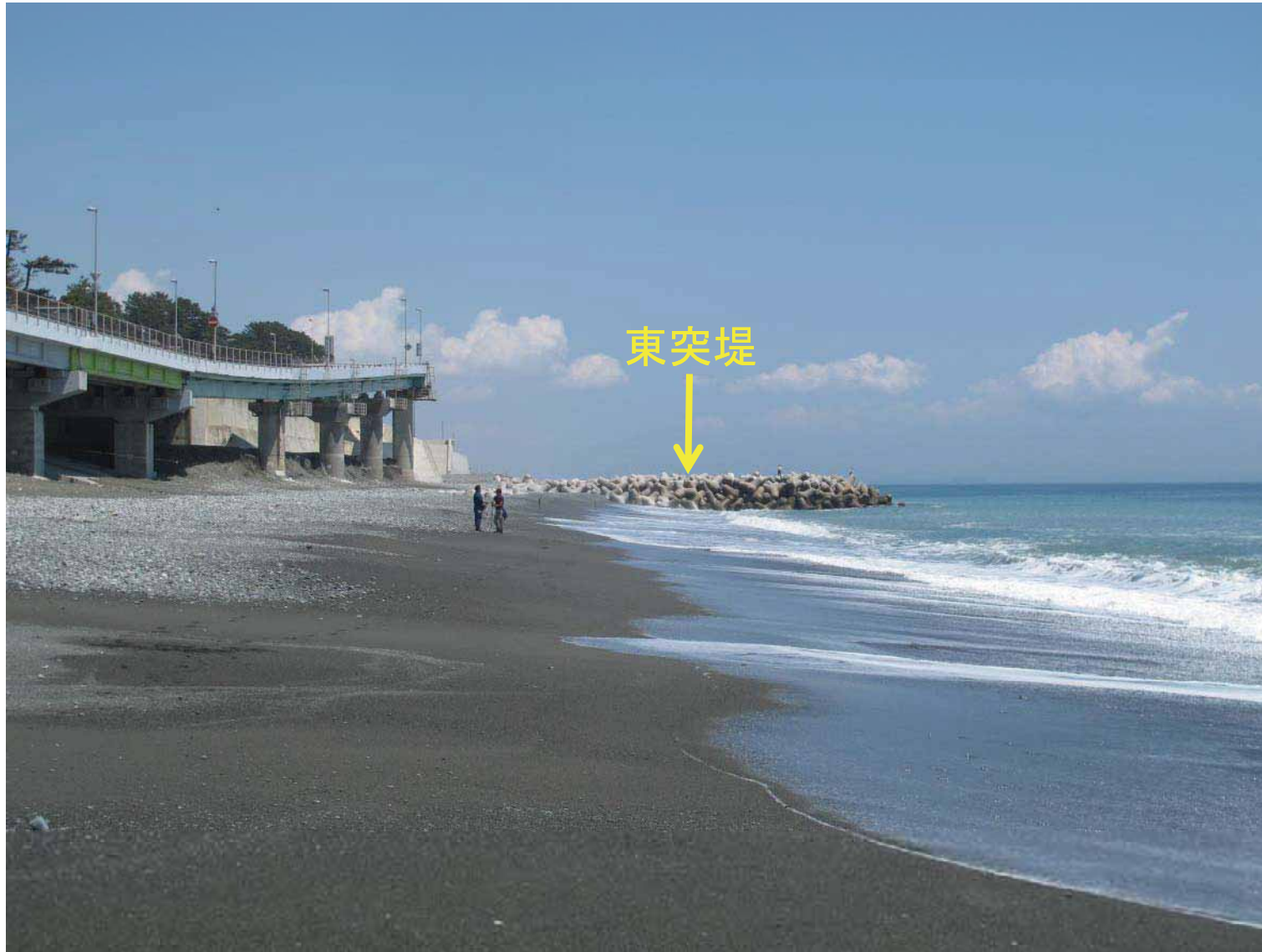
図-26 試験突堤間に形成された砂浜（2014年5月2日）
