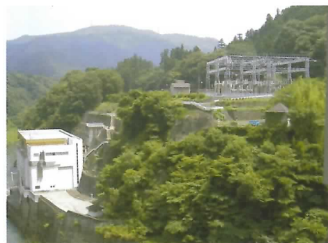
さがみはつでんしょ 相模発電所
