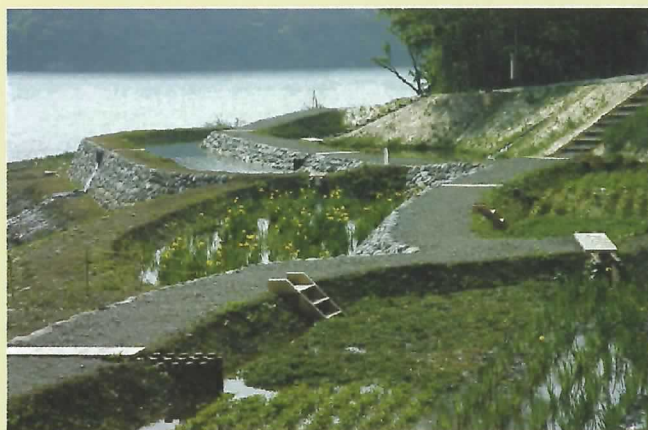
▲棚田に湖水を通して、チツソ・リンなどを取りのぞいています
